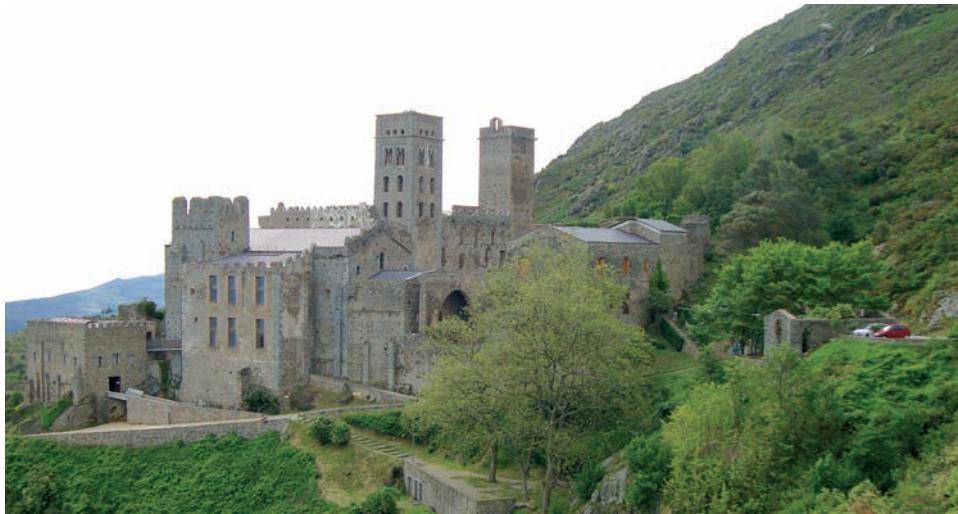
Vista general de San Pedro de Roda.
